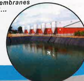
Bassin d'étanchéité EPDM.
